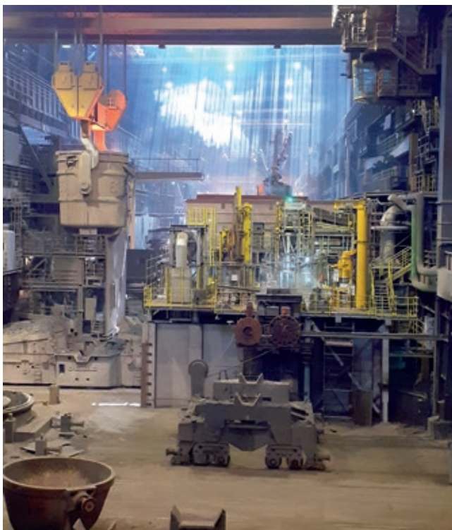
So präsentiert sich der Pfannenaufheizstand von der Rundstranggussanlage aus. Im Vordergrund wird gerade eine Stahlgießpfanne umgesetzt.
